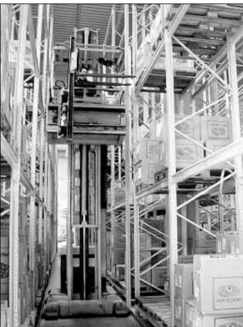
Das erweiterte Hochregallager besteht aus 6000 Palettenplätzen.
